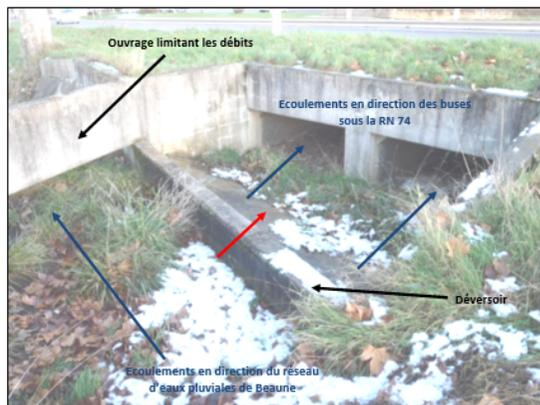
Ouvrage de répartition des écoulements
