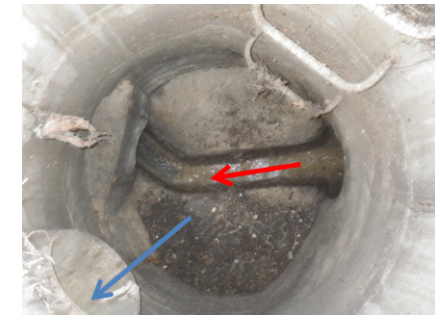
Vue intérieure d'un déversoir d'orage type trop-plein (Repérage)
